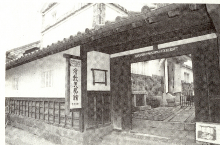
倉敷民藝館・白壁の門
